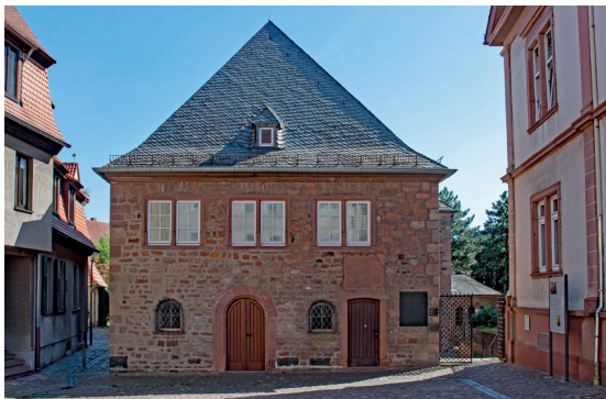
Die mittelalterliche Synagoge in Worms, erbaut 1174/75
